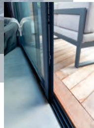
Seuil avec encastrement total intérieur et extérieur
